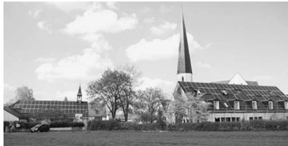
Gemeindehaus Kapelle (links) und Verwaltungs-/Kindergartengebäude (rechts) Kapellenstraße 2 und 5.
